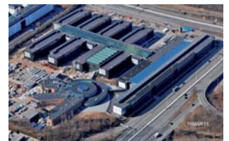
Dong Energy - etape 2
